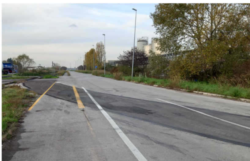
Figura 15 Attraversamento sud di via Majorana, con il ripristino della pavimentazione lungo il vecchio tracciato.
